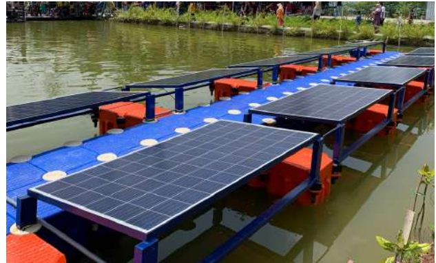
Gambar 1. PLTS Apung Embung Sidobandung ( https://ppns.ac.id/peduli-potensi-energi-terbarukan-ppns-hadirkan-plts-apung-di-desa-sidobandung/ )
